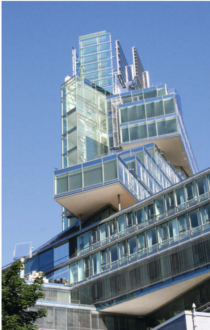
Moderne Architektur: das Verwaltungsgebäude der Norddeutschen Landesbank am Aegi
